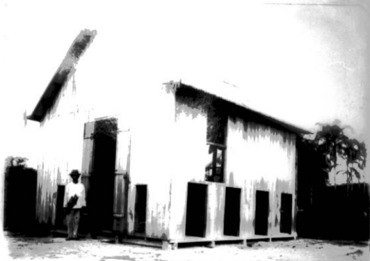
POSTO DO TUIVY - Gallinheiro na sede do posto. Para melhor conforto das especies existentes e em at-
