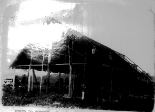
POSTO DO TUHINY - Construção de um barracão para fábrica de farinha e assucar.
