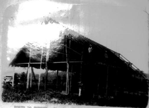
POSTO DO TUHINY - Construção de um barracão para fabrica de farinha e assucar.
