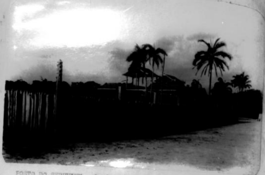
POSTO DO SERUHINY - Jardim com o pavilhão escolar em construção.
